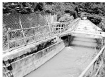
水力発電所に吾妻川の水を運ぶ送水トンネル
