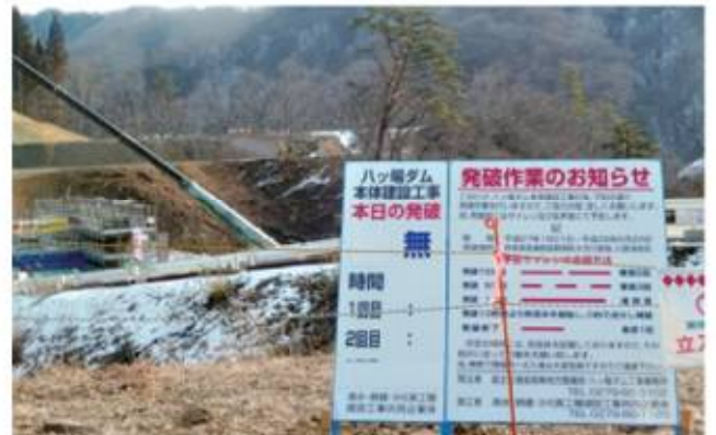
発破作業「今日は中止の」看板。後方の作業ヤードに作業員の姿
