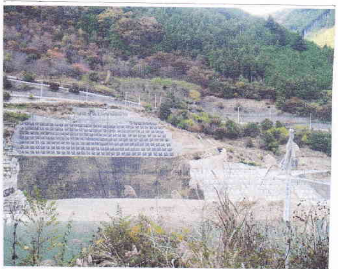
写真②アンカーボルトだらけの滝沢ダム
