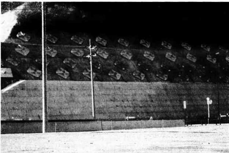
不安をいっぱいかかえた切り土の造成地(川原畑地区)。崩れてくる不安定な法面を、巨大なアンカーボルトをびっしりと打ち込んで押さえている。アンカーボルトの1本1本に地滑り計が取り付けられているという。
