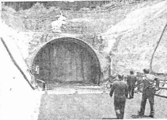
板荷引田トンネル(仮称)の起工式で公開された引田側坑口
